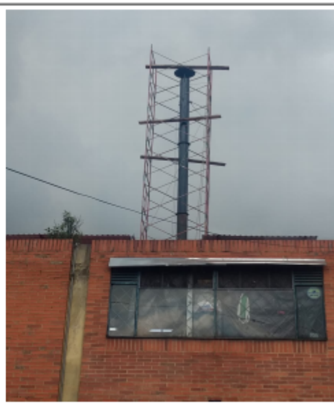
FOTOGRAFÍA No 2 PROCESO DE ADECUACIÓN DE LA ALTURA DEL DUCTO DE LA CALDERA
